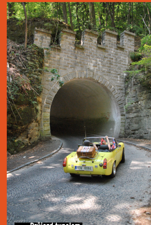
Průjezd tunelem pod hradem Kokořín
